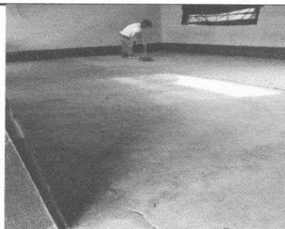
Reparación de piso.
